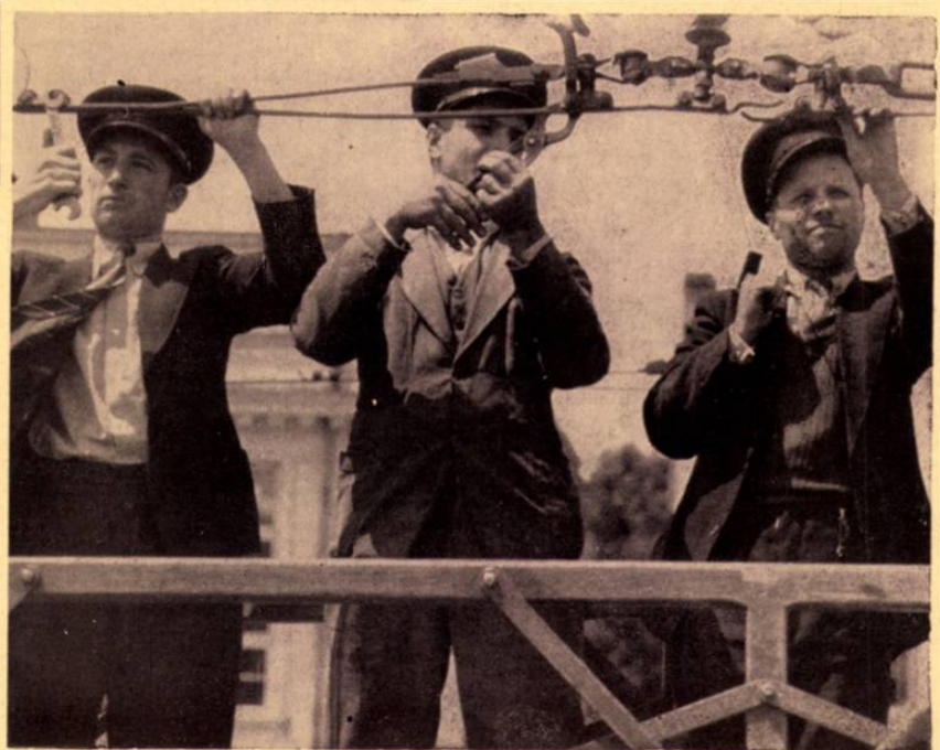
Repararea cablului electric
