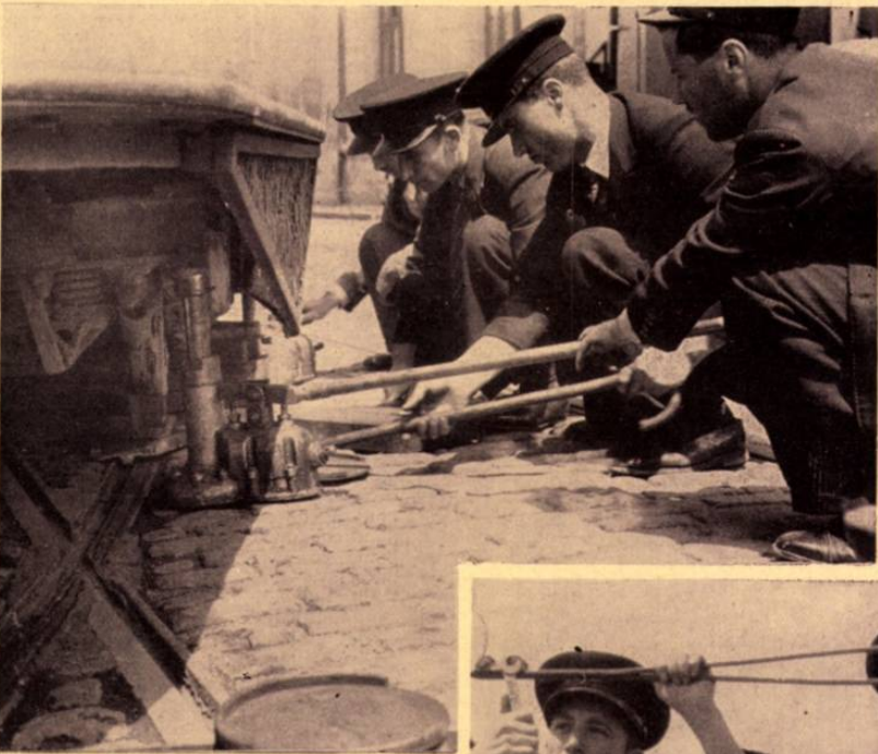
Sus: Sudarea unei linii; dedesubt: Ridicarea unui vagon deraiat
